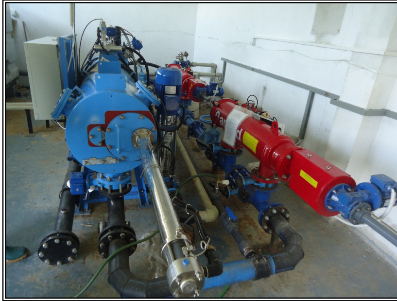
Слика 21. Филтри кои се користат во пречистителната станица за механичко филтрирање на водата
