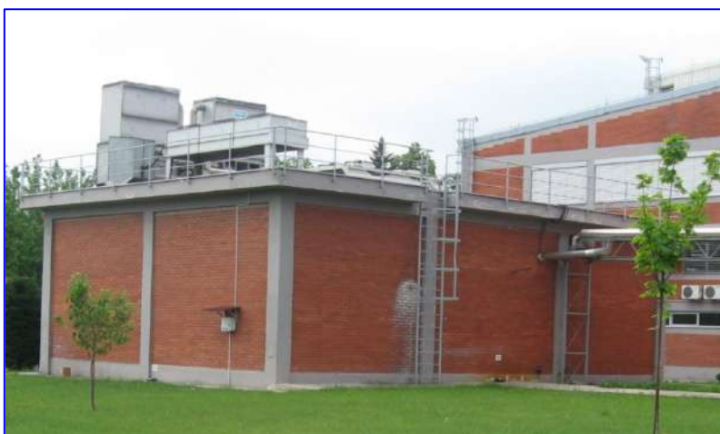
Слика бр. IV.1-6: Подстанција за разладни уреди - надворешен изглед
