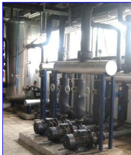
Слики бр. IV.1-7 и IV.1-8: Разладувач (Чилер) и систем од пумпи за циркулација на водата за ладење
