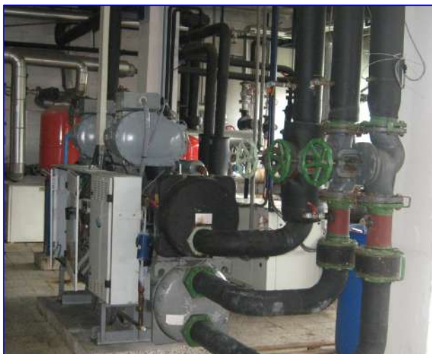
Слики бр. IV.1-7 и IV.1-8: Разладувач (Чилер) и систем од пумпи за циркулација на водата за ладење
