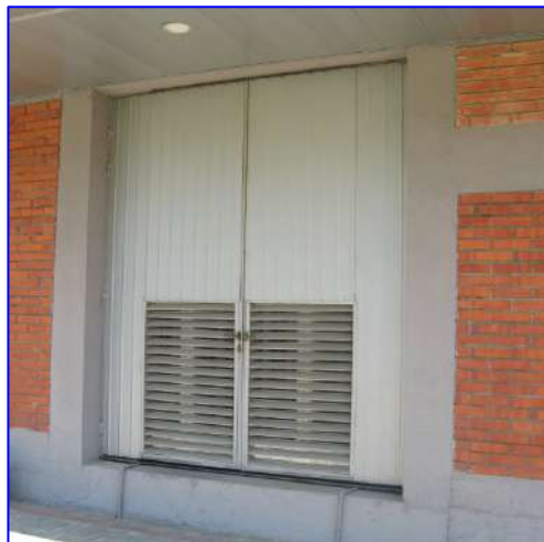
Слики бр. X.1-1 и X.1-2: Просторија во која е сместен компресор за компримиран воздух - извор на бучава
