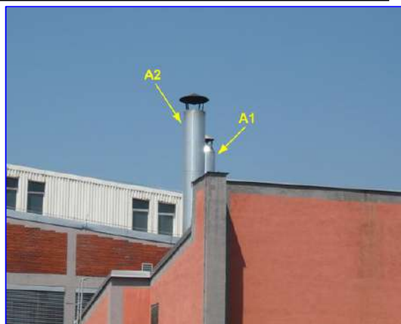
Слики бр. VI.1-1, VI.1-2 и VI.1-3: Местоположбата на испустите А1 и А2 од котлите К1 и К2
